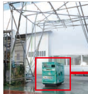
▲ 雨水対策実験実施状況
